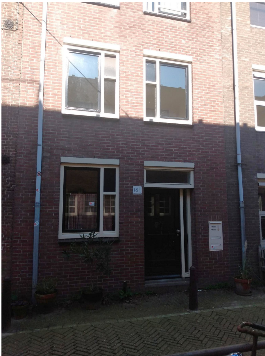
Gezinswoning Palmstraat 18-A, beganegrand+eenhoog
